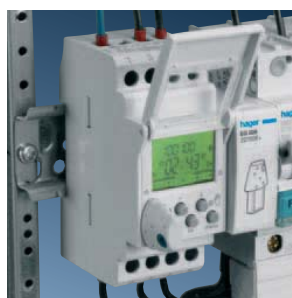
Bezpośrednio po włożeniu klucza programowego uruchamiany jest żądany program. Inna możliwość: bezpośrednie wpisywanie danych na zegarze sterującym.
