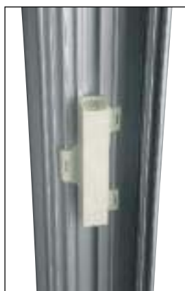
Za pomocą przesuwnej poziomnicy możemy ustawić kolumnę w pionie.
