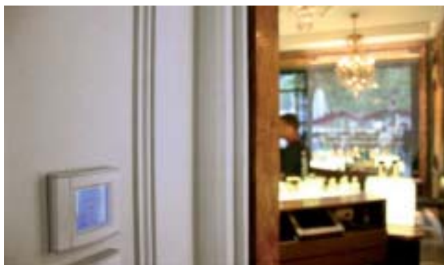
2 contrôleurs d'ambiance par étage suffisent à commander les scénarios d'ambiance
