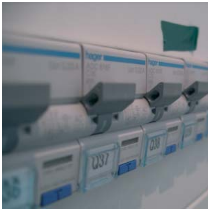
7 armoires Quadro pour la distribution en étage.
