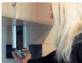
Bordsmodul Pop Up installerad i överskåpet i ett kök.
