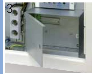
Medialåda ingår i infällda fasadmätarskåp
