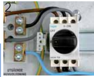
Huvudbrytaren efter mätning
