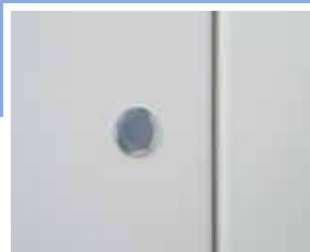
Hål för antenn i dörr
