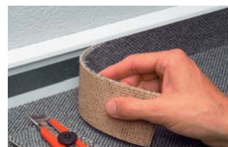
Canal special pentru montarea mochetei
