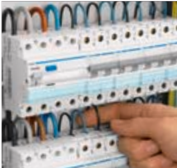
God kontakt sikres av nye, isolerte kabelklemmer
