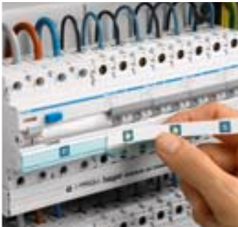
Tydelig visning av kontaktens stilling, både ved manuell betjening, samt ved både overbelastning og kortslutning, gir stor sikkerhet
