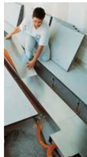
Eksempel på forlegging i installasjonsgulv
