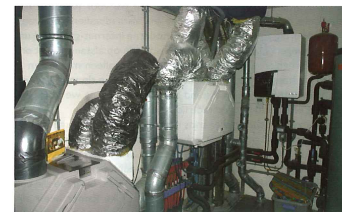
Technische ruimte met onder meer balansventilatie en warmteterugwinning
