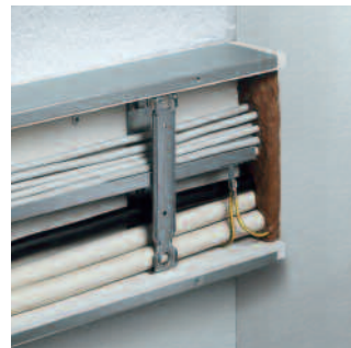
Brandwerende pasta zorgt voor een betrouwbare afdichting van wand en plafond.
