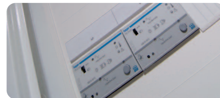
In de verdeler zijn behoorlijk wat dimmers aanwezig voor de verschillende ruimtes in huis.
