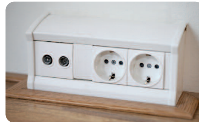
Het stopcontact is eenvoudig te verplaatsen door de tegels van de Mind Air Floor te verwijderen, de bekabeling te verleggen en daarmee ook het stopcontact een paar meter naar links of rechts te verplaatsen.
