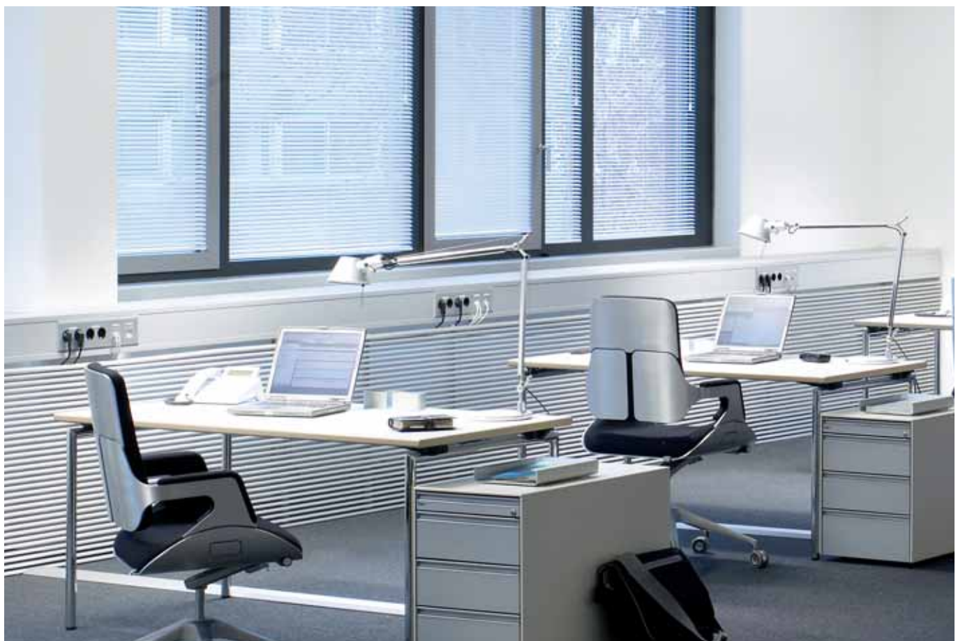
Brüstungskanal BR mit Lamellenverkleidung für die Heizkörper – eine saubere und aufgeräumte Lösung. Anbindung der Arbeitsplätze über trittfeste Aufbodenkanäle AKA aus Aluminium.
