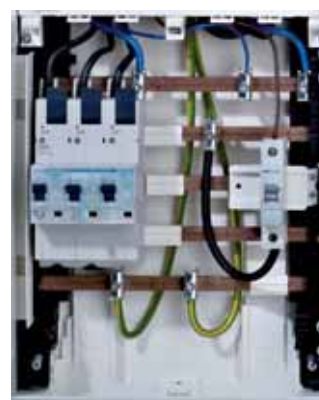
Leitungsschutzschalter 10 A/25 kA, MB197 als Schutzeinrichtung.
