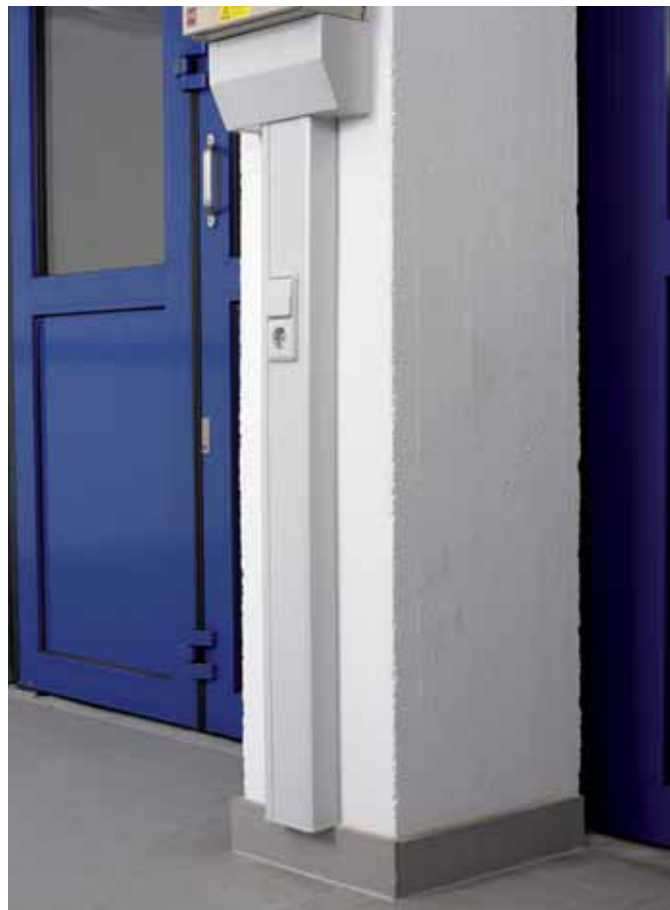
Elegantní řešení: přívod vedení k řídicímu modulu v tehaitu.BRN propojovacím kanálem.
