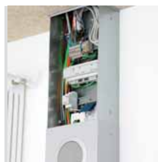
Dostatek místa pro kabely za horním krytem.
