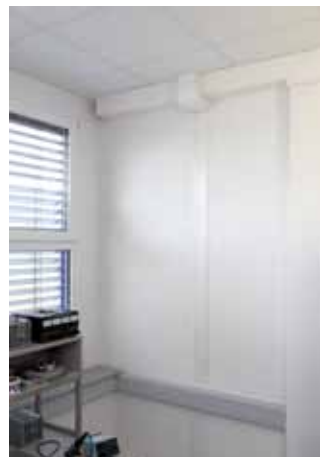
Do stěny integrovaný parapetní kanál tehalit.BKIS od Hagera vede vedení od stropu k parapetnímu kanálu tehalit.BRN.
