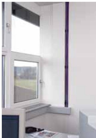
Do stěny integrovaný parapetní kanál tehalit.BKIS od Hagera vede vedení od stropu k parapetnímu kanálu tehalit.BRN.
