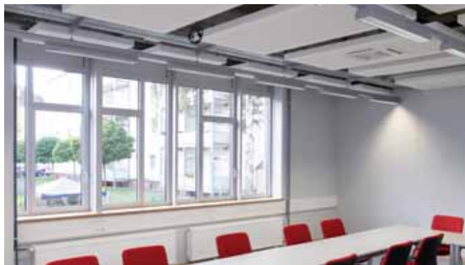
Přívod vedení do dvojitých parapetních kanálů tehalit.BR z ocelového plechu je v seminářích místnostech proveden okenními parapety přes sloupce tehalit.DA
