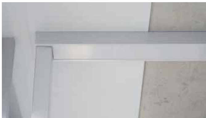
Systém parapetních kanálů tehalit.BR z ocelového plechu překlene dráhu mezi kabelovou lávkou a prostorovým sloupem tehalit.DA na stropě. Pro čisté napojení byly použity kryty tehalit.BR vyvinuté speciálně pro tento účel.
