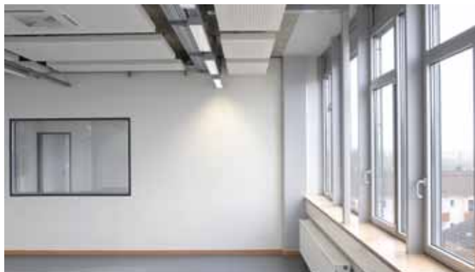
Provedení sloupů tehalit.DA skrz okenní parapety se ukazuje jako praktické a snadno realizovatelné řešení.
