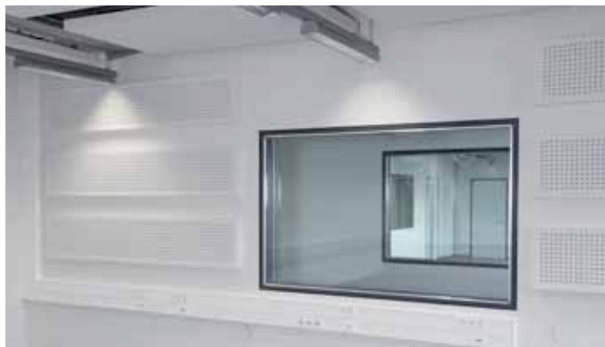
Dvojitě provedené parapetní kanály tehalit. BR z ocelového plechu zásobují místnosti silovými, datovými a komunikačními přípojkami.
