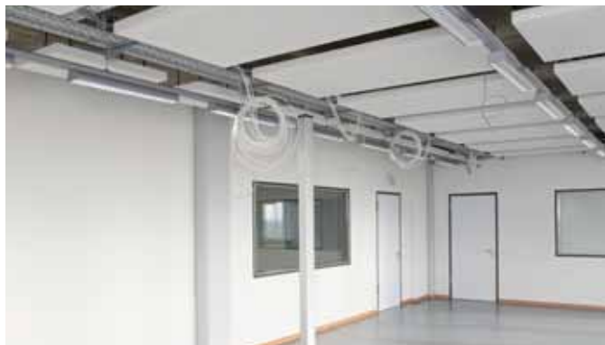
Prostorové sloupce DA200 poskytují pracovním v místnosti potřebnou připojovací techniku. Vedení se přivádí přímo z otevřených kabelových lávek.
