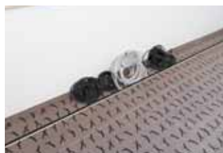
Do systému podlahových kanálů tehalit. BKB se pokládají všechna vedení a přípojky.
