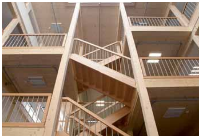
Dřevostavba kladla na montáž flexibilní elektroinstalace zvláštní požadavky.
