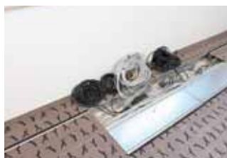
Do systému podlahových kanálů tehalit. BKB se pokládají všechna vedení a přípojky.
