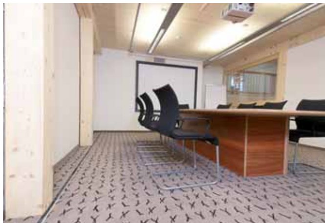
Celá elektrotechnická infrastruktura je umístěna neviditelně v parapetním podlahovém kanálu tehalit.
