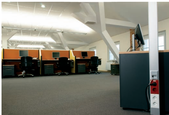
Při zajištění silnoproudých přípojek se také spolehli na prostorové pilířky tehalit.DA.
