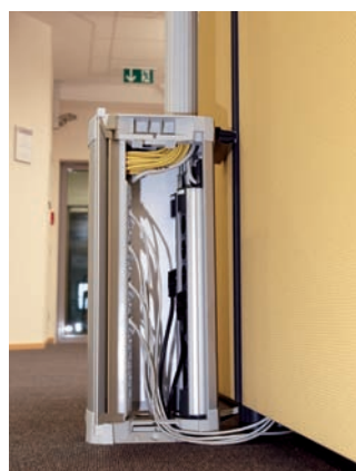
Datové přípojky jsou skryté za dveřmi prostorových rozvaděčů; elektrické přípojky pro úklidový personál jsou naproti tomu otevřené přístupné.
