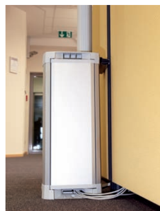
Pro zvládnutí náročné instalace se integroval rozvaděč typu tehalit.RS do prostorových sloupů DA 200.
