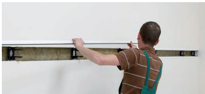
Boční profilové lišty se jednoduše zacvaknou na přídržovací sponky a zajistí.
