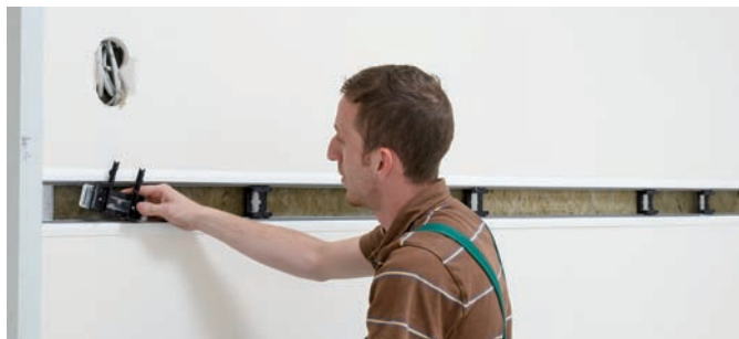
V prvním kroku elektrotechnik umístí na profily přídržovací sponky.
