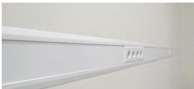
Abschließend sind nur noch Deckel und Blenden zu montieren – fertig!
