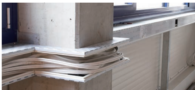
Pomocí tvarovek systému parapetních kanálů tehalit. BRS z ocelového plechu se dají piliře bez problémů obejít.
