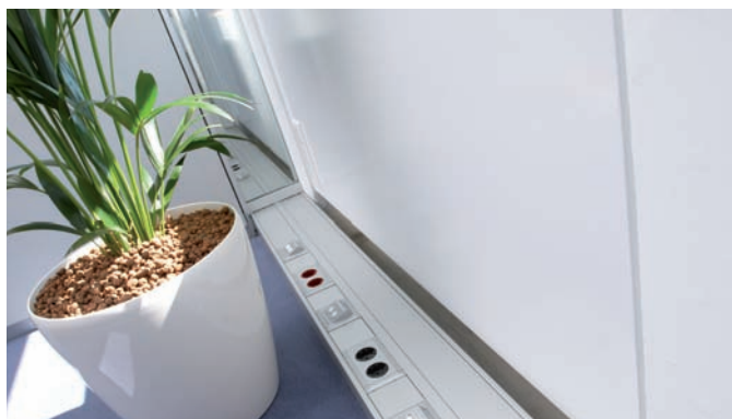
V oblasti pracovišť obchodníků a oddělení IT byl instalován dvouutorový tehalit.BR, přičemž jedna část slouží jen pro uložení enormního množství vedení.
