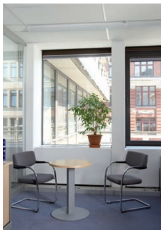
V oblasti pracovišť obchodníků a oddělení IT byl instalován dvouutorový tehalit.BR, přičemž jedna část slouží jen pro uložení enormního množství vedení.
