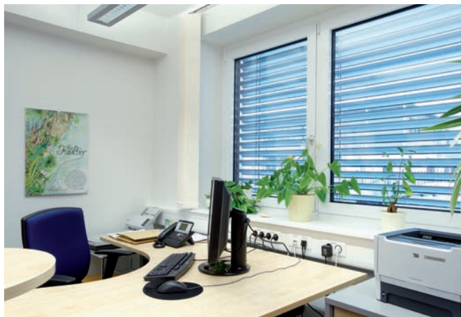
Systém parapetních kanálů tehalit.BRN zásobí pracoviště silovými a datovými přípojkami.
