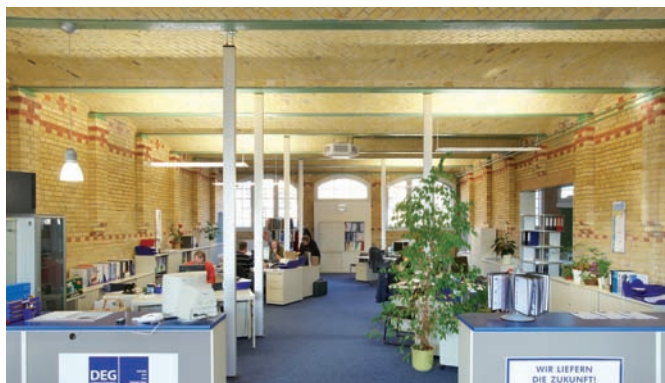
Prostorové sloupy tehait.DA jsou napájeny z rozvodného kola nad klenbovými stropy.
