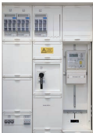
Technika přiznává životnímu prostředí: nepřímé měřicí zařízení k měření 150 kW blokové kotelny
