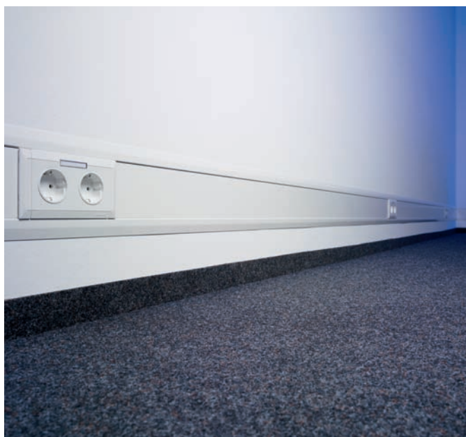
Světelné ladění ve školící místnosti se dá různě obměňovat. Až při podrobnějším pozorování se pozná, že do stěny integrovaný parapetní kanál tehalit.BKIS byl „nenápadně“ namontován do výšky 30 cm jako kanál podlahové lišty.
