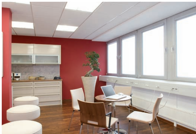
Také v pobytových částech poskytuje systém parapetních kanálů tehalit.BRN všechny potřebné datové a silové přípojky.
