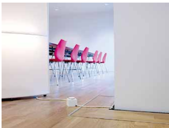
Podlahové kanály výrazně zvyšují variabilitu prostoru
